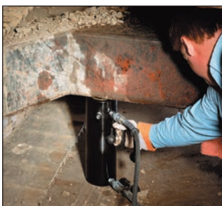
◀ Un RAR-506 se colocó fácilmente bajo un bulldozer para reparar un componente del bastidor.
